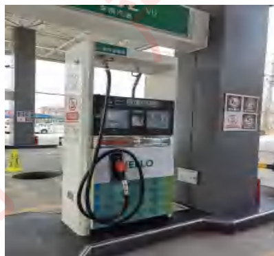
防撞柱、加油机拉断阀及警示标识、灭火器
